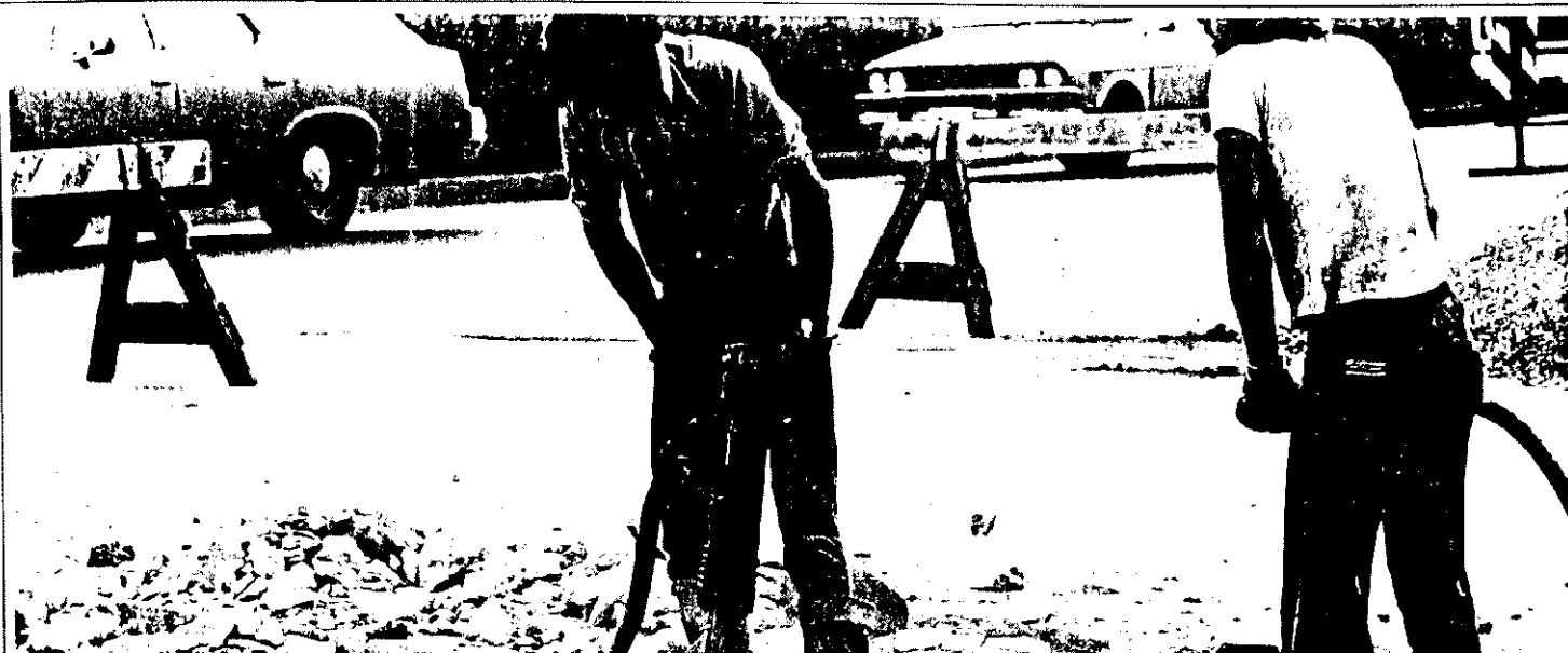
Le travail avec des marteaux pneumatiques est sans doute un des plus générateurs de vibrations nocives pour le corps humain. (Coutorsse - Office de la construction du Québec)
