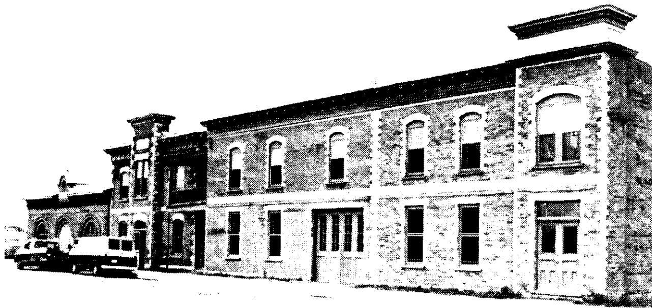
La station de pompage et l'aqueduc de Valleyfield en 1983.
