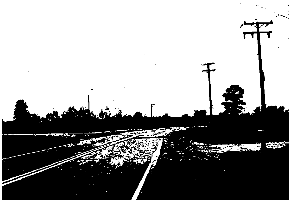
I32 et intersection Rg Picoudie, dir. ouest; courbe prononcée; visibilité très réduite.
