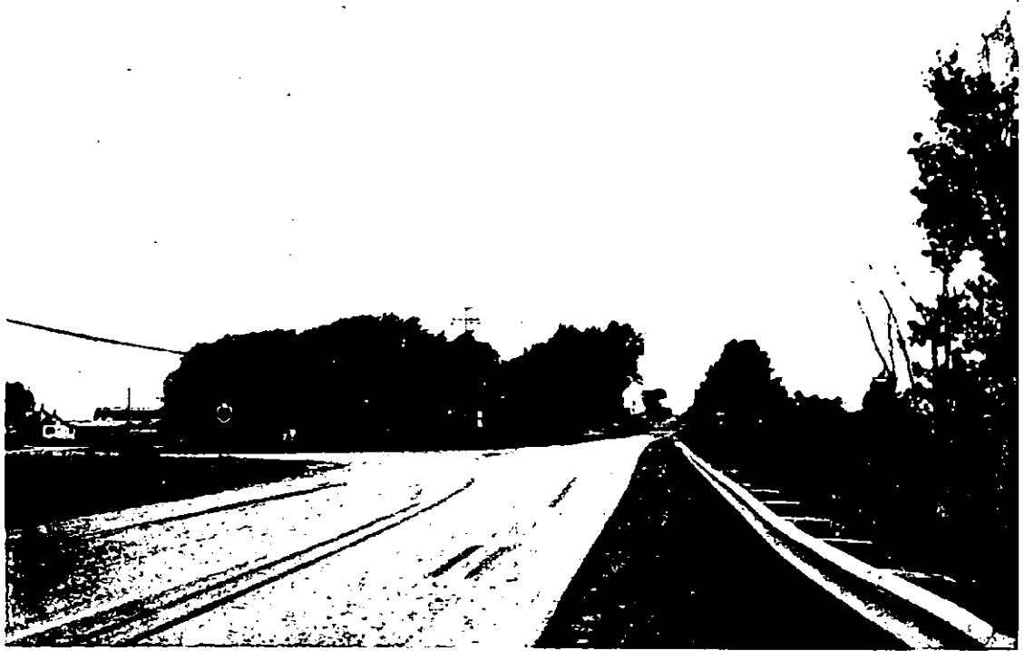
Route 23I, direction Nord, Intersection avec Rg St-Simon (Montée des 60) Présence d'arbres
